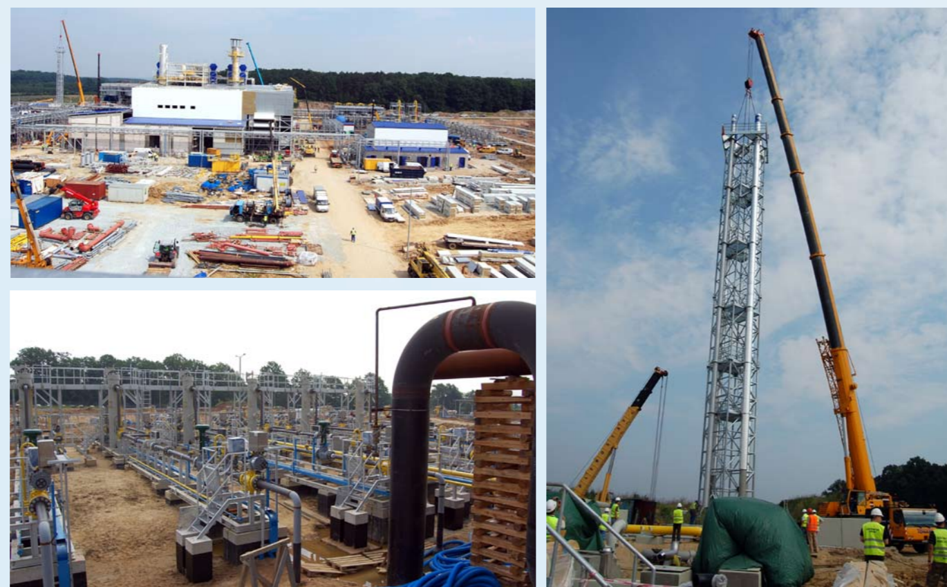
Rozbudowa części napowierzchniowej PMG Wierzchowice (podetap 1,2 mld m 3 ) rozpoczęła się w 2009 r., foto: archiwum Oddziału, PBG S.A.
